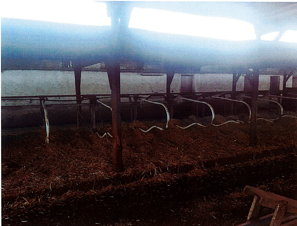
Figure 3. Logettes vues du couloir d'alimentation (deux vues).
