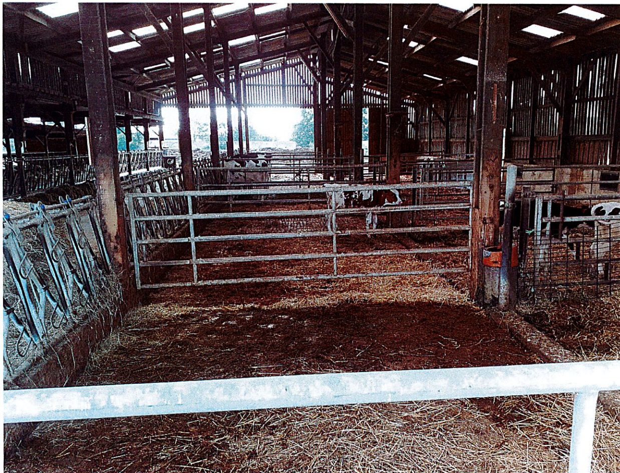
Figure 2. Couloir béton devant l'aire paillé.
