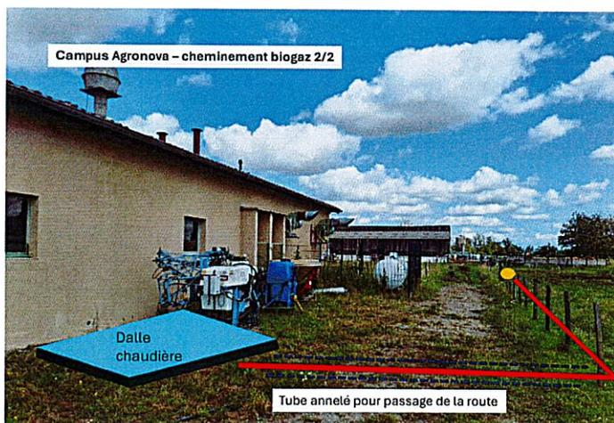
Figure 2. Positionnement de la dalle béton pour réception de la chaudière.
